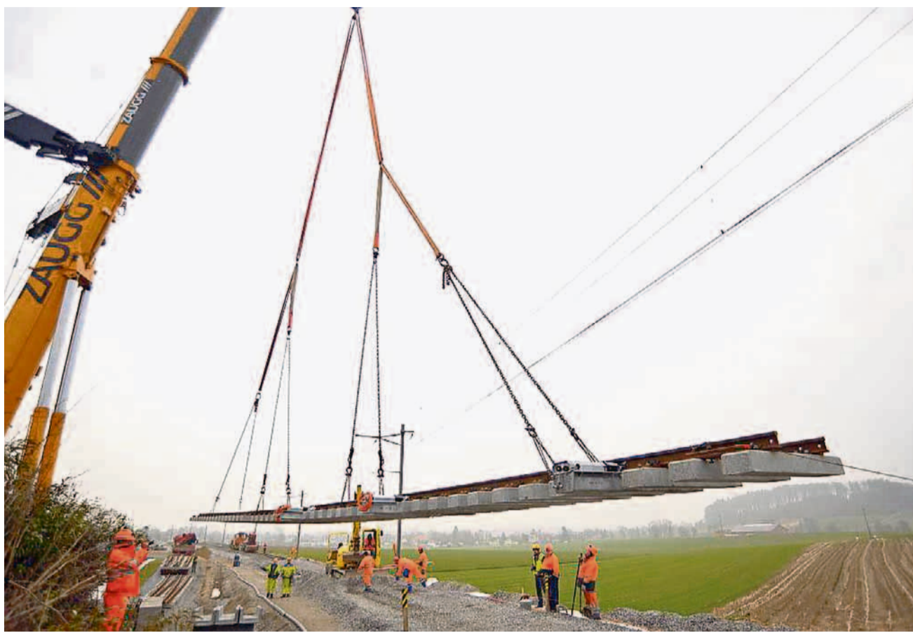
Das grosse Weichenteil schwebt durch die Luft und wird danach auf dem Schotter platziert.
