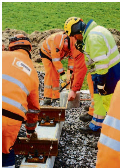
Mit den Landeskoordinaten wurden die Gleissicherungspunkte vermessen und vor Ort angezeichnet. Eingepasst wurde das Weichenteil dann mit einfachsten Mitteln: einer gespannten Schnur und einem Doppelmeter.
